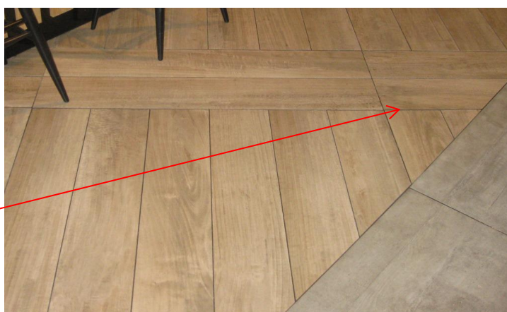
Figur 4a og b: Eksempel hvor fliser på 200 x 1200 mm legges i ulike lengderetninger og i kombinasjon med 450 x 900 mm fliser ga høydesprang på over 2 mm.
