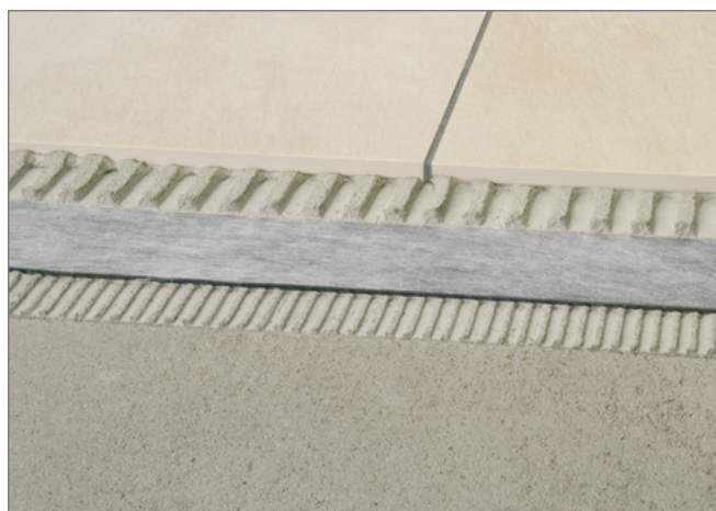
Figur 5: Eksempel på 3 – 5 mm tykkematte som limes til underlaget
