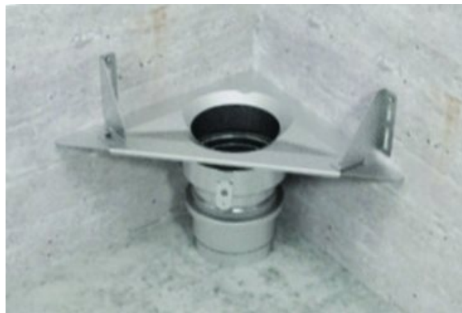
Figur 8a og b: Systemet man benyttes enten med klemring for membran eller et egnet butylbånd festes til limflensen
